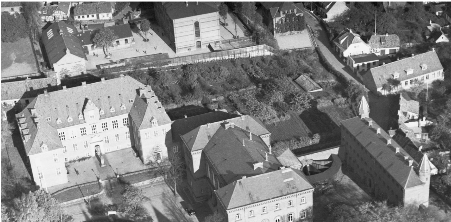
Figur 17. Udsnit af luftfoto fra perioden 1932-1947, der viser det berørte område set fra SSV. Øverst i midten ses sydgavlen i Østre Skole, i dag del af VUC, og umiddelbart syd for gavlen ses en øst-vest orienteret støttemur med stræbepiller, som optager terrænspringet mellem det lavere liggende terræn i erosionskløften og det højere liggende terræn eller plateau mod nord. Placeringen er sammenfaldende med den trappe, som blev anlagt i begyndelsen af 1970'erne i stedet for dele af støttemuren. Betonfundamentet A7, som er registreret under trappen i S1 og S2, må være identisk med den øst-vest orienterede støttemur på fotoet, og som stadigvæk findes vest for trappen.
