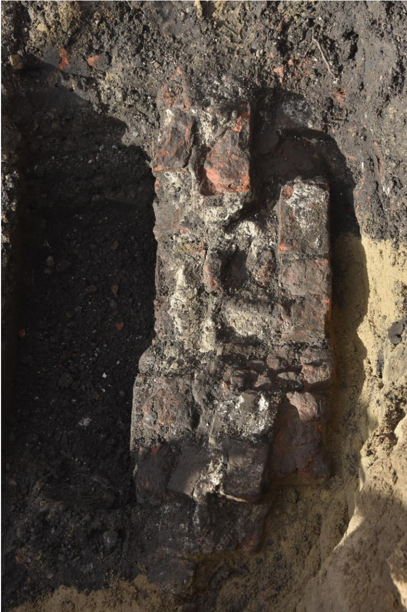
Figur 12. S1. Detail af mur/klostermur K1 (A1-A3) samt foranliggende betonmur A7 mod syd. Set fra oven/øst.
