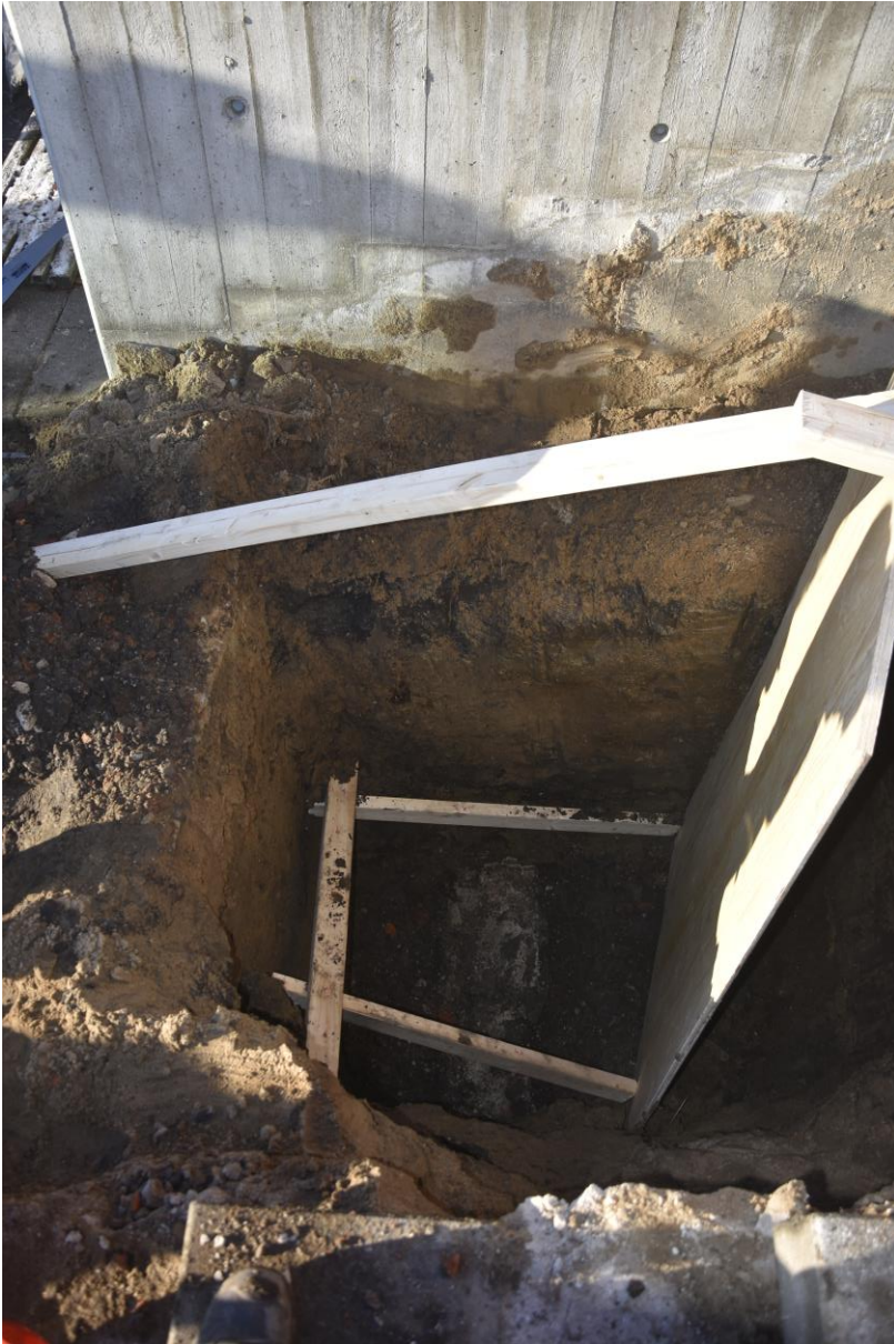
Figur 15. S2. Oversigtspfoto med mur/klostermur K1 og afstivning af udgravning. Set fra øst.
