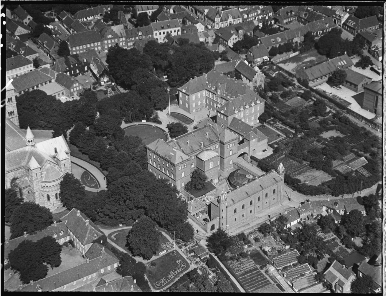
Figur 9-5 Luftfoto fra tiden omkring 1930.
