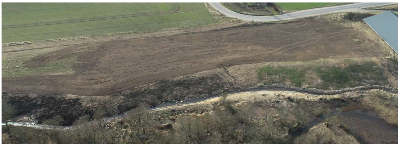
Terrænregulering: for at give plads til det nye åbne vandløb langs møllesøen, er skrænten rykket et stykke længere ind på marken.
