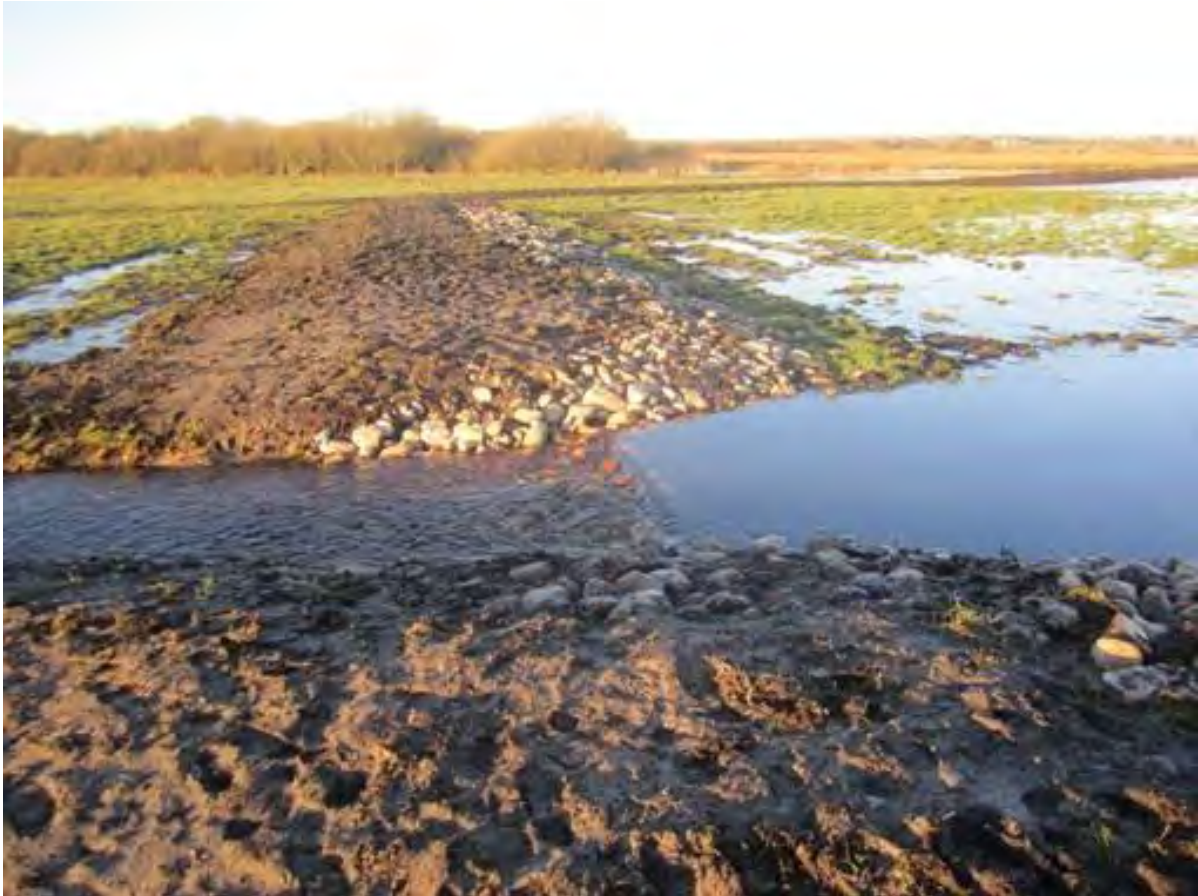
Figur 38 Eksempel påstensikret overløbskant
