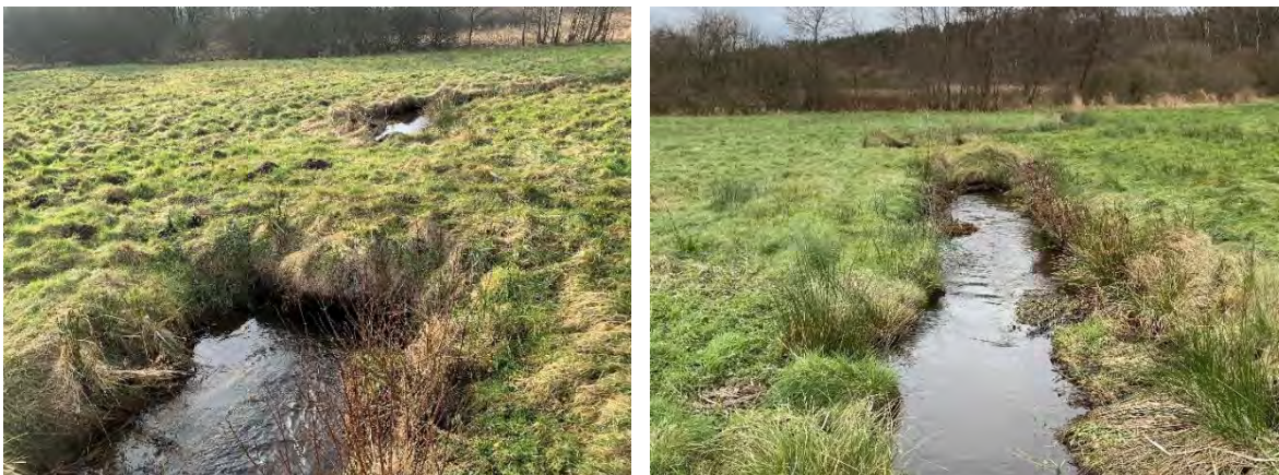
Figur 15 Eksisterende rørbro i St. 2.452-2.456 m
