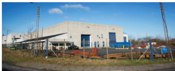
Vestasbygningen som omdannes til GAME Streetmekka
