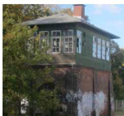
Kommandoposten før renovering
