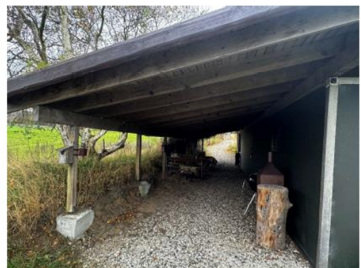
Overdækning mod nord/øst
